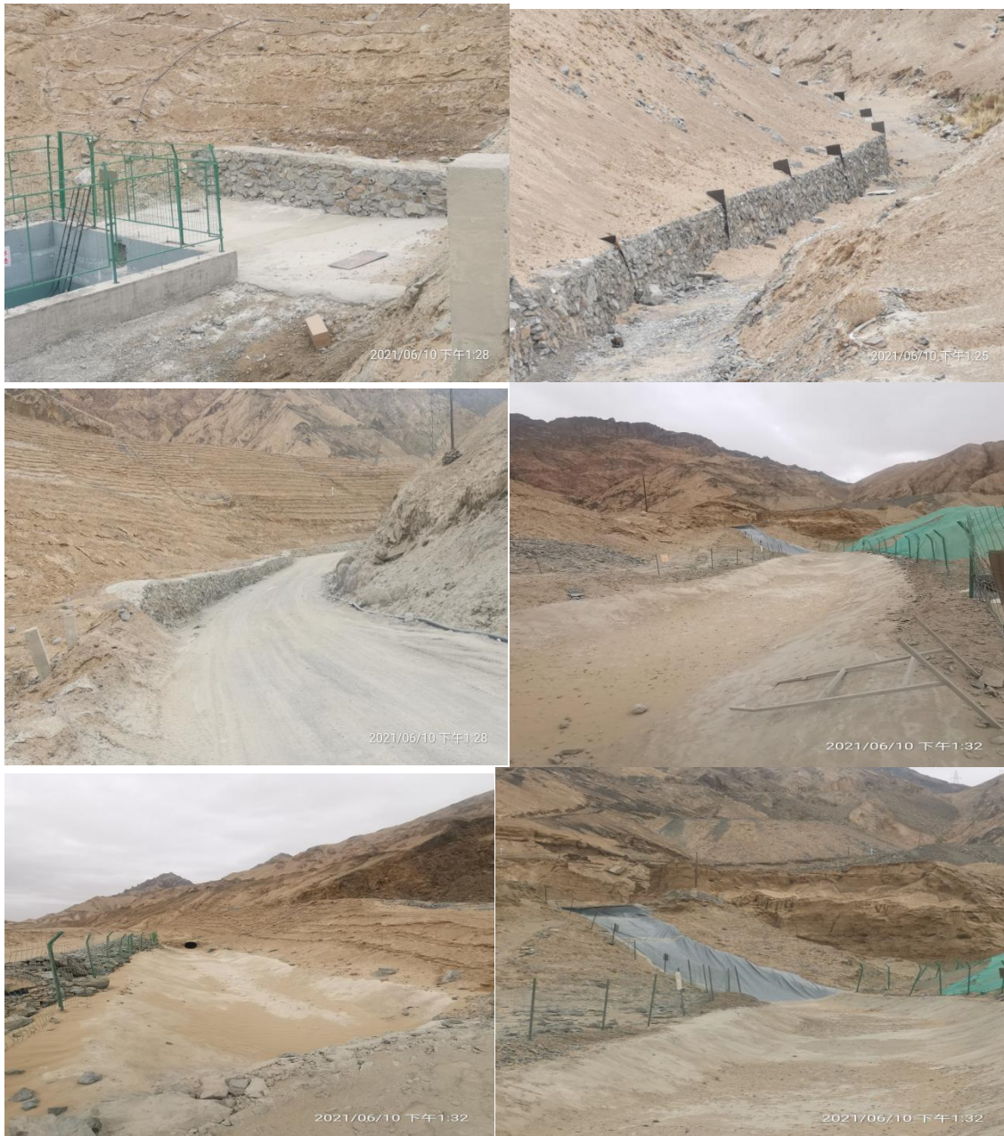
图 1-6 排水沟和挡土墙
