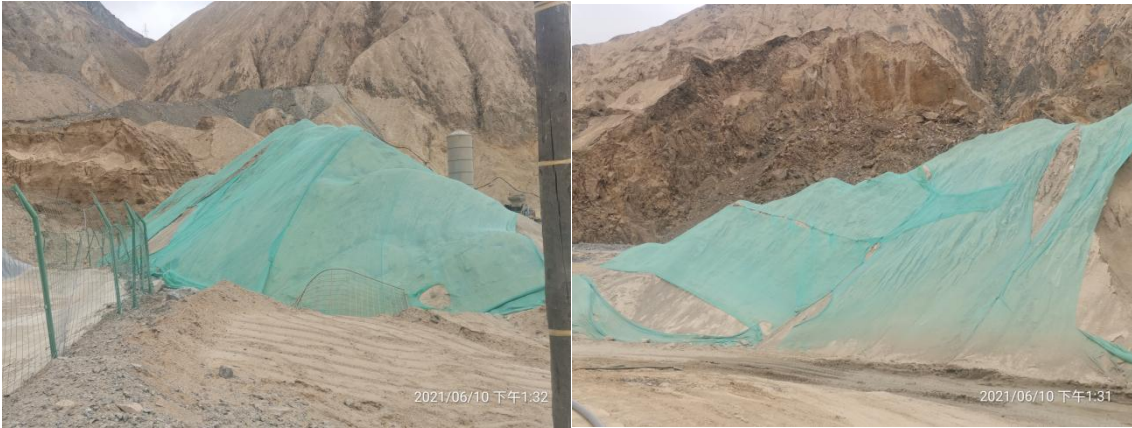
图 13-14 临时堆土苫盖
